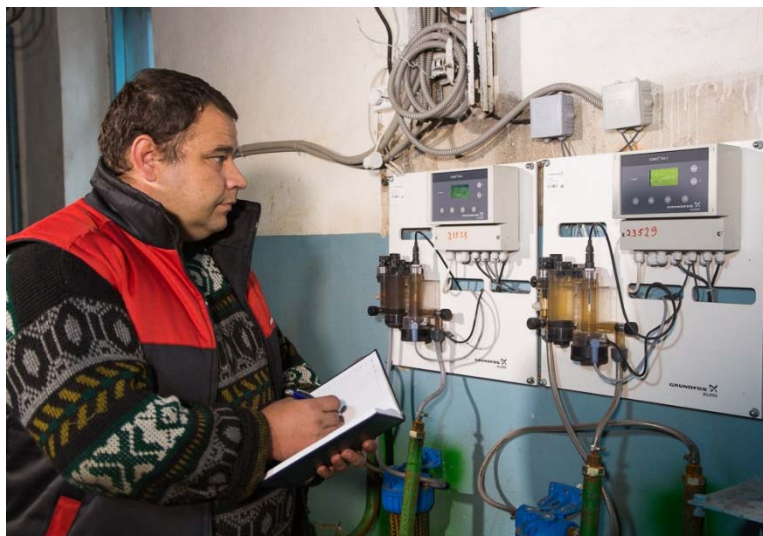
Фото: Работник предприятия «Оскемен Водоканал» проверяет показания остаточного свободного хлора
