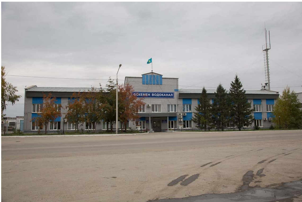
Фото: ГКП «Оскемен Водоканал», г. Оскемен, Казахстан
